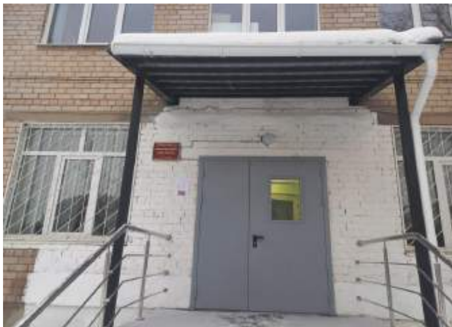
Ремонт входной группы
