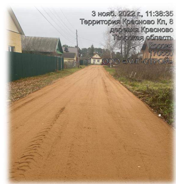
После окончания работ
