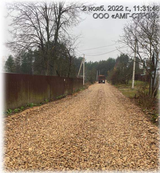
До начала работ
