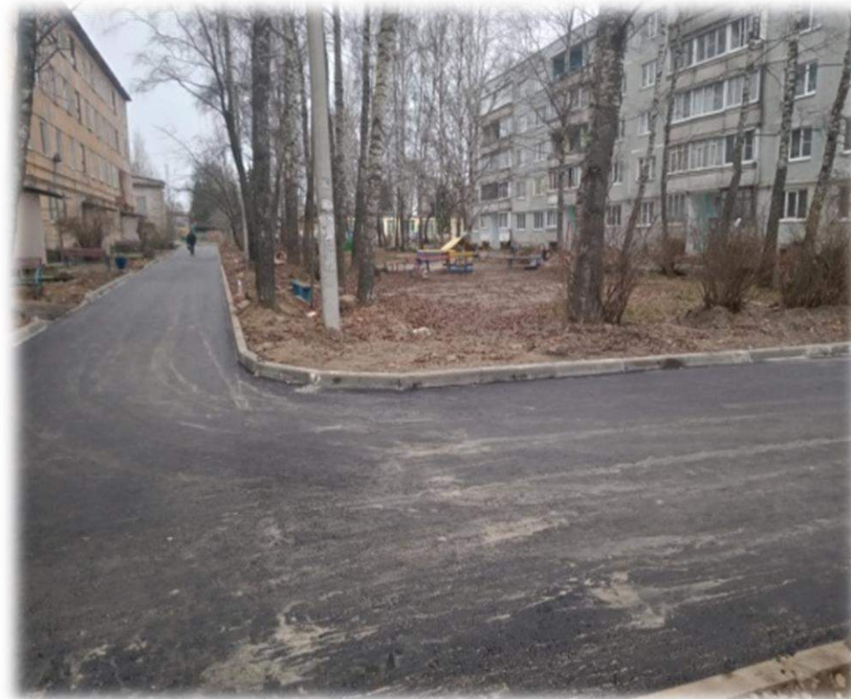
После окончания работ
