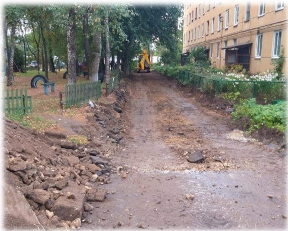
До начала работ
