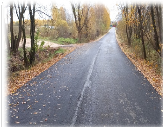
После окончания работ
