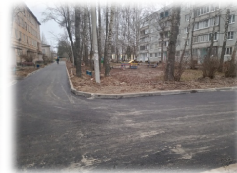
После окончания работ
