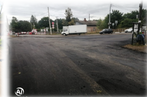
После окончания работ
