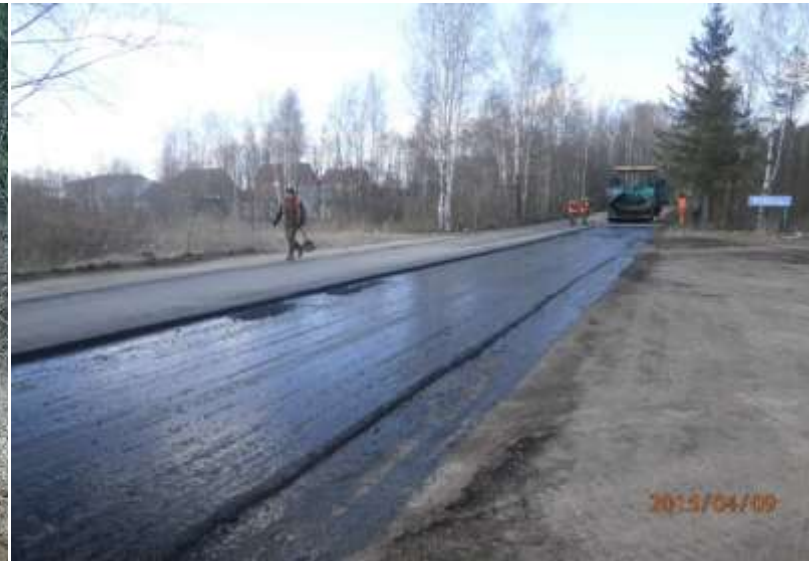
Ремонт дороги к музею Калининского фронта
