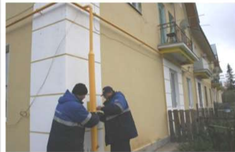
Работы по газификации многоквартирных домов в поселке Восток
