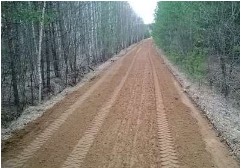
Дорога Колталово-Сельцо-Подъельшево после проведенной планровки
