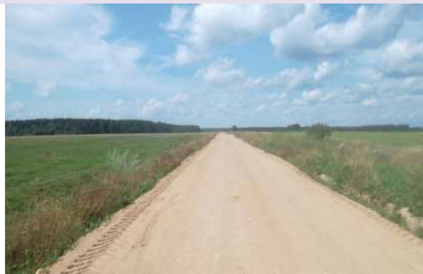
Отремонтированный участок автодороги Кувшиново-Тургиново
