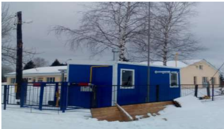
Теплогенераторная установка детского сада в д. Даниловское
